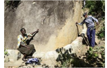
Einfach, aber effizient Die Rinne um den Felsen leitet das Regenwasser in einen Tank. Wenige Tage Regen genügen, um ihn zu füllen.
