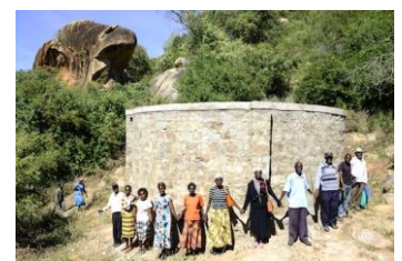
Der Stolz der Gemeinde In diesem 75 Kubikmeter großen Tank wird das Wasser gespeichert.
